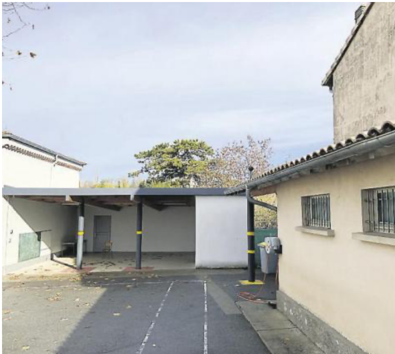
Le préau avec les toilettes PMR et le futur local technique
